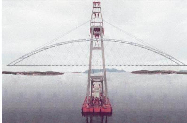
Figura 29 Sollevamento scheletro arco con catena temporanea ponte Åkvik Sound, campata da 135 m
