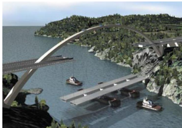
Figura 27 Montaggio impalcato ponte Svinesund
