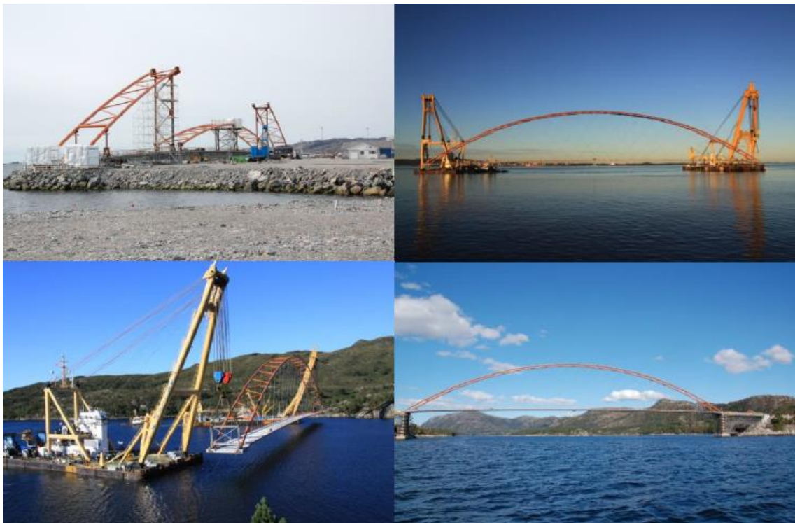
Figura 28 Quattro step della costruzione del Ponte Brandanger (tratta da "About the Network Arch", 2011)
