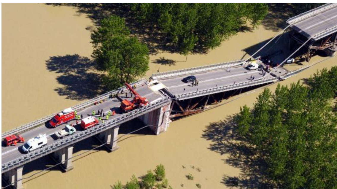
Figura 1 Crollo Ponte inondazione fiume Po 2009
