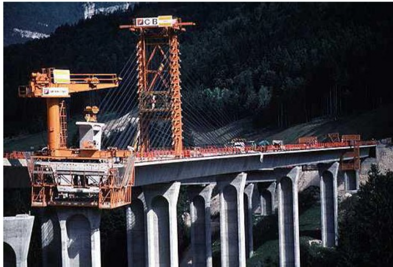
Fig. 1.10 - Impalcato sostenuto da stralli temporanei
