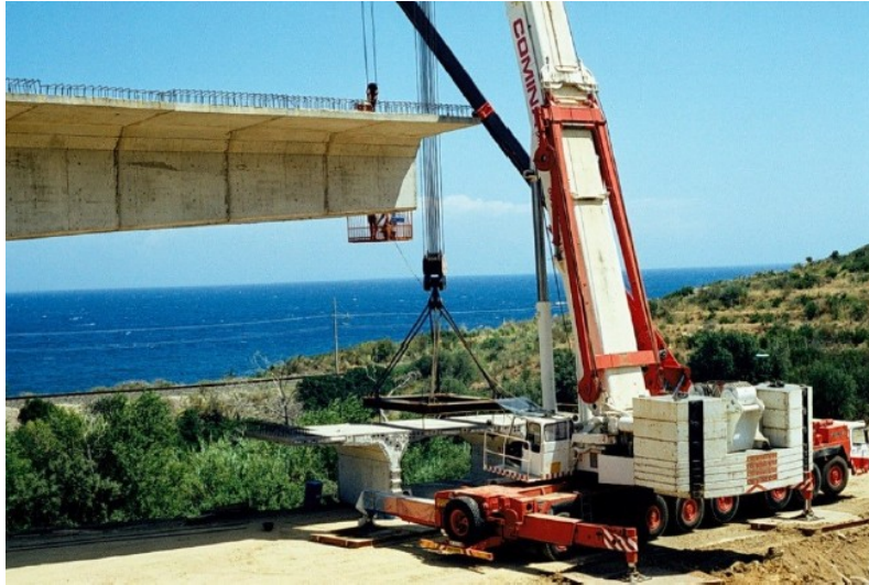
Fig. 1.9 - Varo di un concio prefabbricato dal basso
