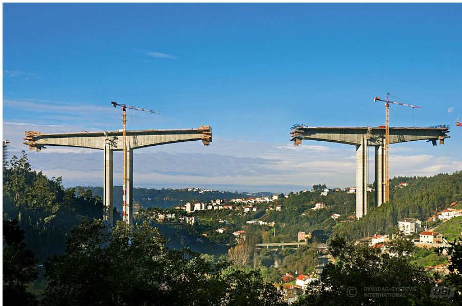
Fig. 1.5 - Cantilever con conchi gettati in opera
