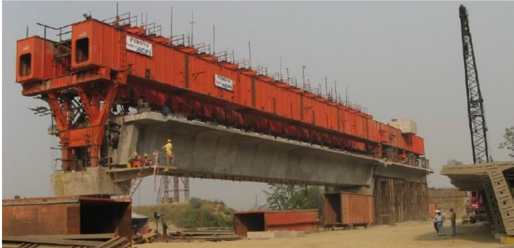
Fig. 1.7 - Conci allineati per la precompressione
