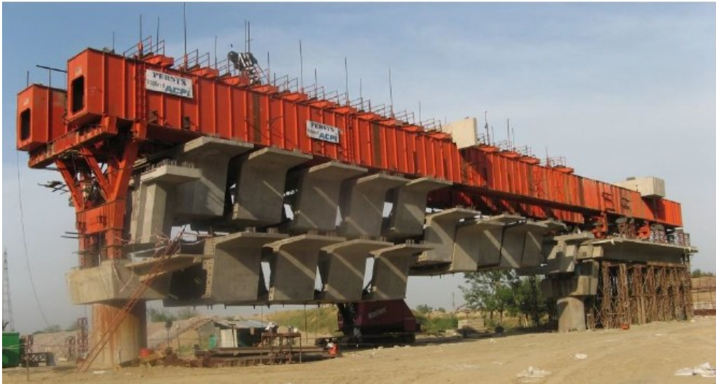
Fig. 1.6 - Sollevamento e allineamento conci
