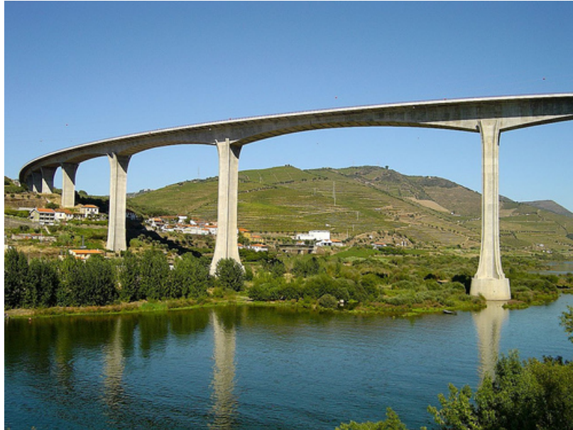
Fig. 1.1 - Viadotto con impalcato a cassone in c.a.p.
