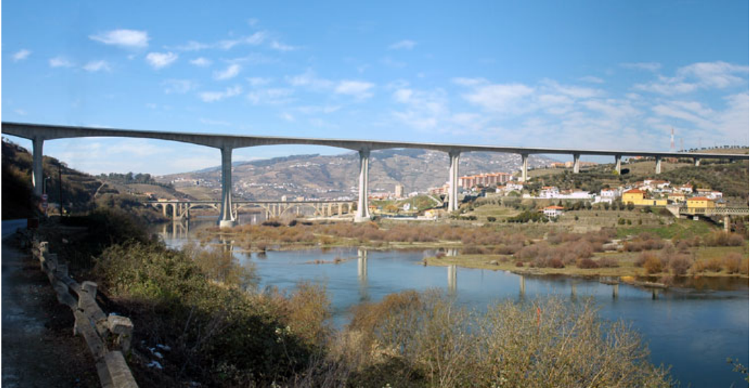
Fig. 1.2 - Viadotto con impalcato a conci
