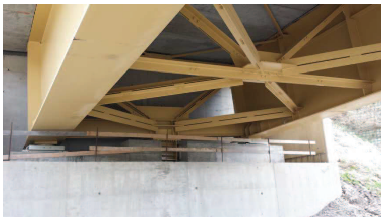
Figura 1. 15-Spalla A, particolare appoggio multidirezionale
