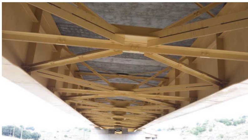
Figura 1. 11-Controventi di piano e traversi
