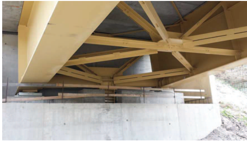
Figura 1. 12-Controventi di piano e traversi in spalla
