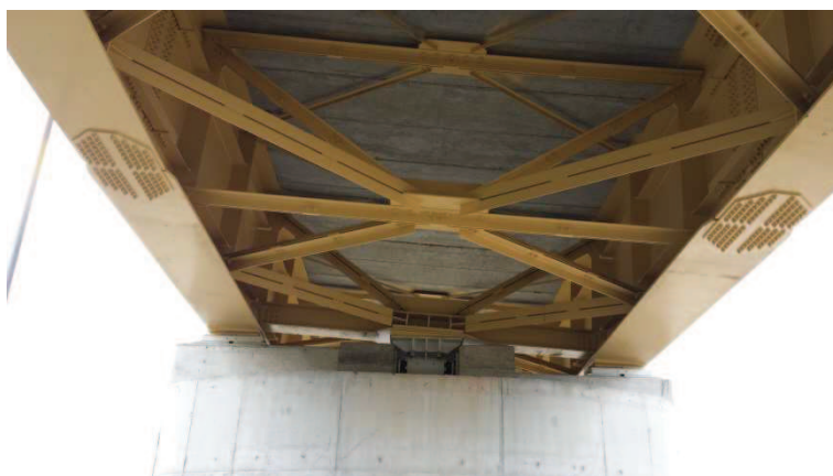
Figura 1. 16-Pila 2, particolare dispositivi di vincolo
