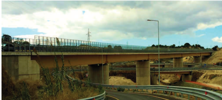
Figura 1. 3-Foto del viadotto Molona
