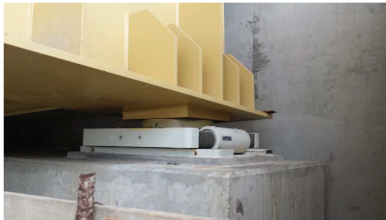
Figura 1. 14-Particolare appoggio multidirezionale Spalla A
